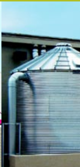
Tanques donde se junta agua de lluvia para las plantas en el centro de jardinería, Austin, TX
